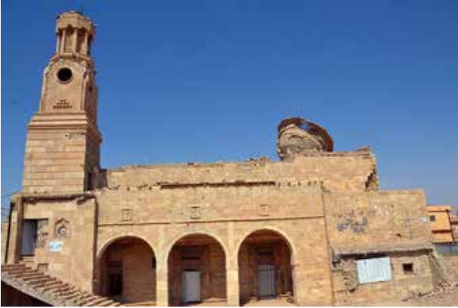
Die innen völlig zerstörte Georgskirche in Mosul. Der IS baute in der Kirche Bomben.
